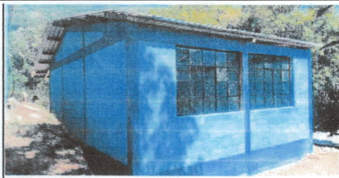
Foto 1: Instalación de cemento corrido de block
