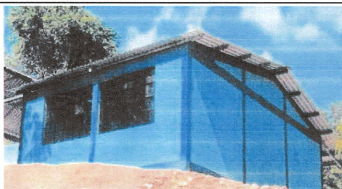
Foto 4: Instalación de pared en módulo tipo pórtico
