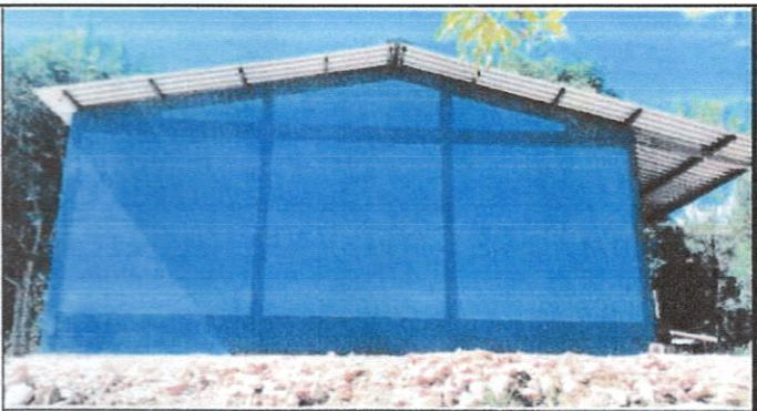
Foto 3: Instalación de pared en módulo tipo pórtico
