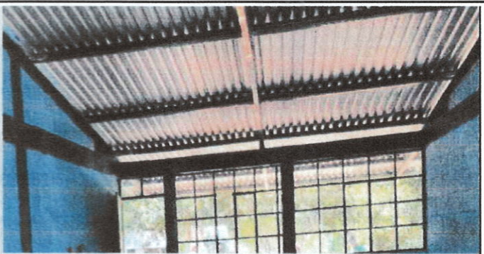
Foto 5: Instalación de estructura de techos cubierta de láminas en módulo tipo pórtico calibre 26
