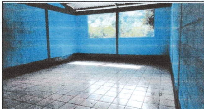
FOTO 2: Instalación de plancha de concreto con piso de color en módulo tipo pórtico
